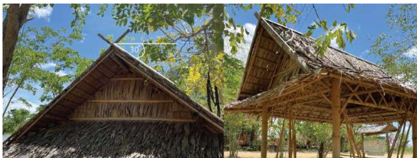
ภาพที่ 5 ลักษณะความลาดเอียงของหลังคา
