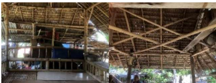
ภาพที่ 3 ลักษณะการยึดโครงสร้างหลังคาบ้านไม้ไผ่และเสาคาน
