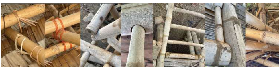
ภาพที่ 8 การเก็บข้อมูลการยึดชิ้นส่วนขององค์อาคาร
