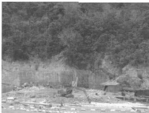
ภาพที่ 5.10 การก่อสร้างโรงบำบัดน้ำเสีย หาดตาแหวน
