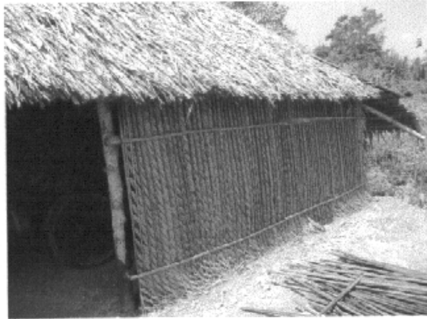
ภาพที่ 5.18 การทำข้างฝาจากโดยใช้ทางจาก
