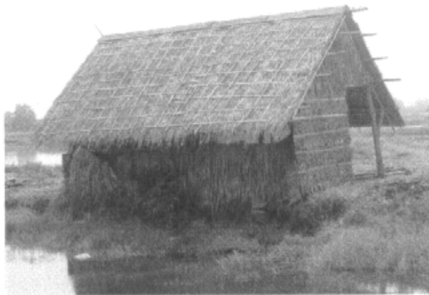
ภาพที่ 5.17 การมุงหลังคาแบบขัดแตะ
