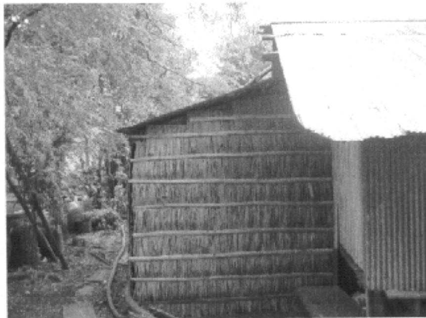
ภาพที่ 5.19 การทำข้างฝาจากแบบขนานโดยใช้ตักจาก
