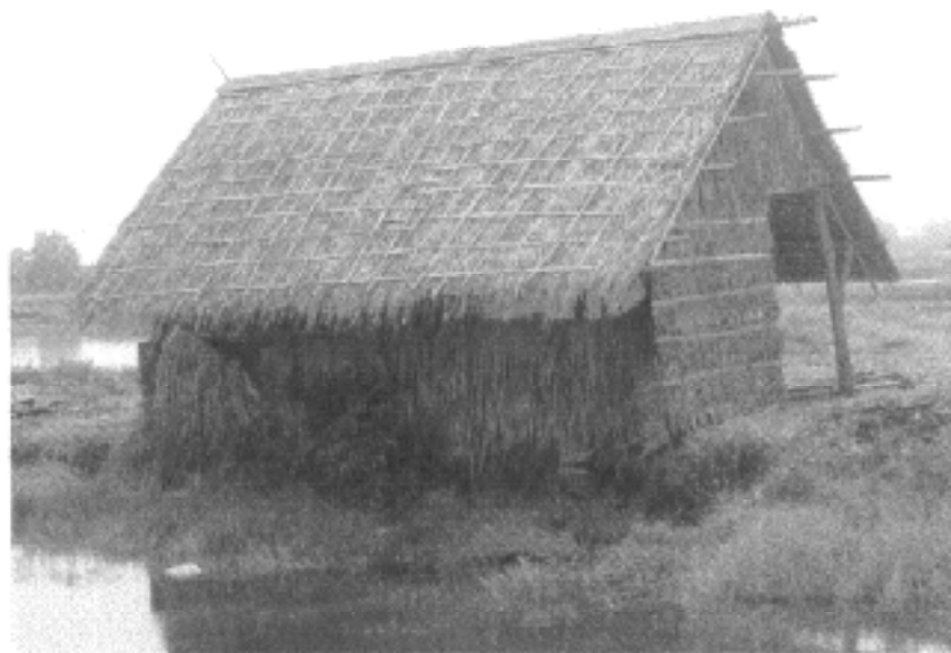
ภาพที่ 5.17 การมุงหลังคาแบบขัดแตะ
