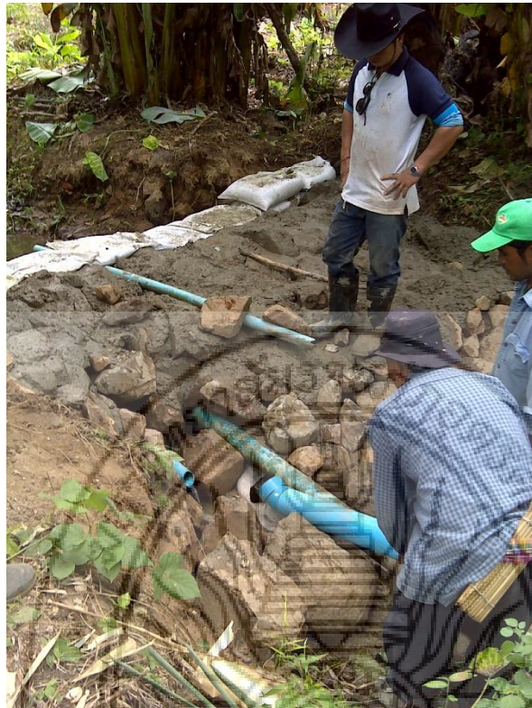
ภาพที่ 4.49 การวางท่อเพื่อนำน้ำจากฝายชะลอน้ำไปใช้ในแปลงเกษตร
