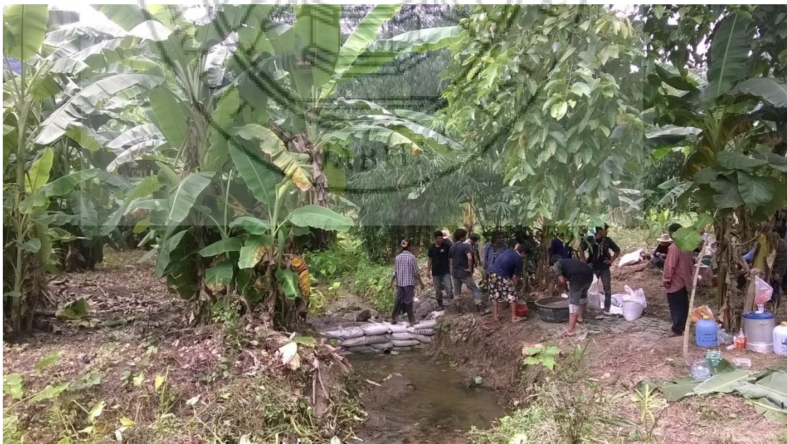
ภาพที่ 4.48 การสร้างฝายชะลอน้ำพื้นที่ต้นน้ำขุนผางใหญ่
