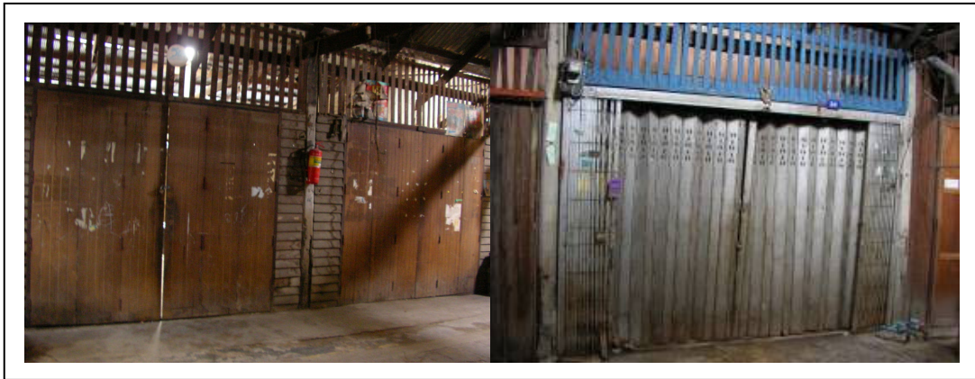
ภาพที่ 4.44 อาคารที่ถูกปิดลงใช้แค่เก็บของ ไม่มีผู้อยู่อาศัย ทำให้บรรยากาศภายในชุมชนเงียบมาก ที่มา ถ่ายจากสถานที่จริง , 2552
