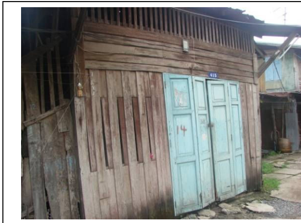
ภาพที่ 6.19 ลักษณะช่องเปิดชุมชนคลอง 3 ที่มา ถ่ายจากสถานที่จริง, 2552
