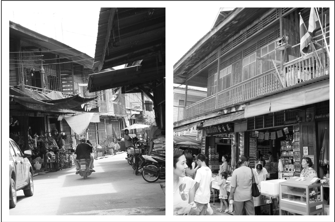
ภาพที่ 5.13 ห้องแถวไม้ สถาปัตยกรรมที่คนสามชุกภาคภูมิใจ
