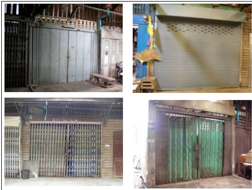
ภาพที่ 4.26 ประตูเหล็กที่ทำขึ้นใหม่
