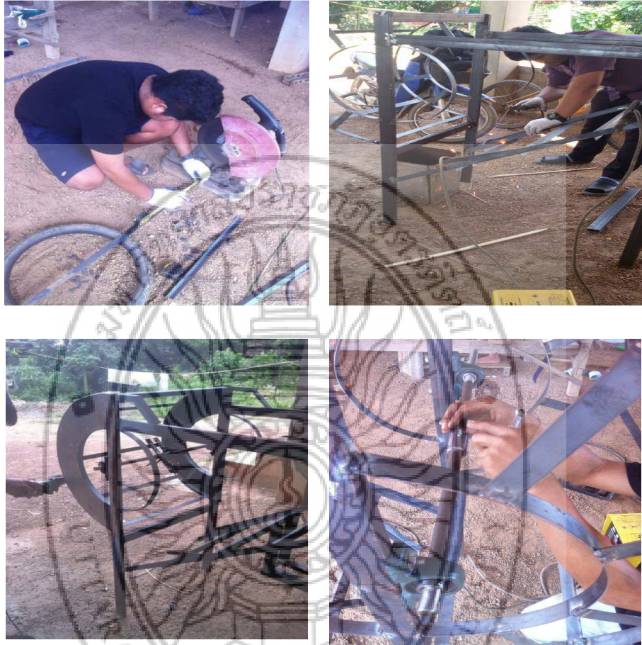
ภาพที่ 2ก ผู้ช่วยนักวิจัยลงมือสร้างเครื่องทำความสะอาดเม็ล็ดพื้นฐ่ต้นแบบ
