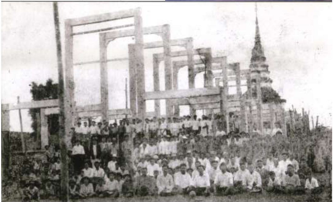
ภาพขณะสร้างวิหารทองวัดพระธาตุจอมปิง ครูบาศรีโฆทัย นำช่าง พ.ศ. ๒๔๖๔ เมื่อตีเสาทอง
