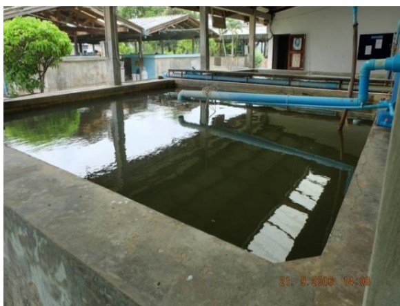
ภาพที่ 4.24 บ่อปรับสภาพน้ำเพื่อนำไปเพาะเลี้ยงปลาในศูนย์วิจัย
