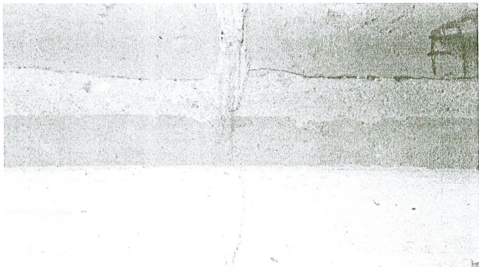
รูปที่ 4.12 ตัวอย่างการ crack ของผนังเปล่า 2
