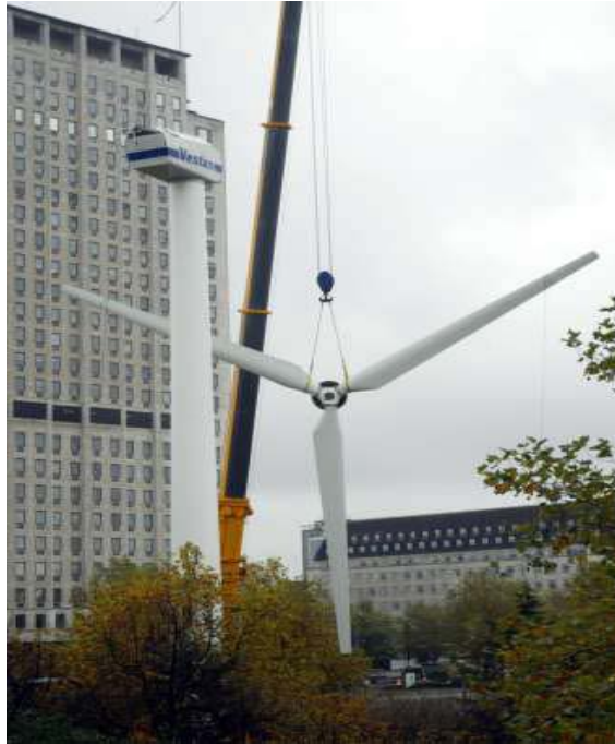
รูปที่ 2.33 แสดงลักษณะใบพัดของกังหันลมแบบแนวแกนนอน
