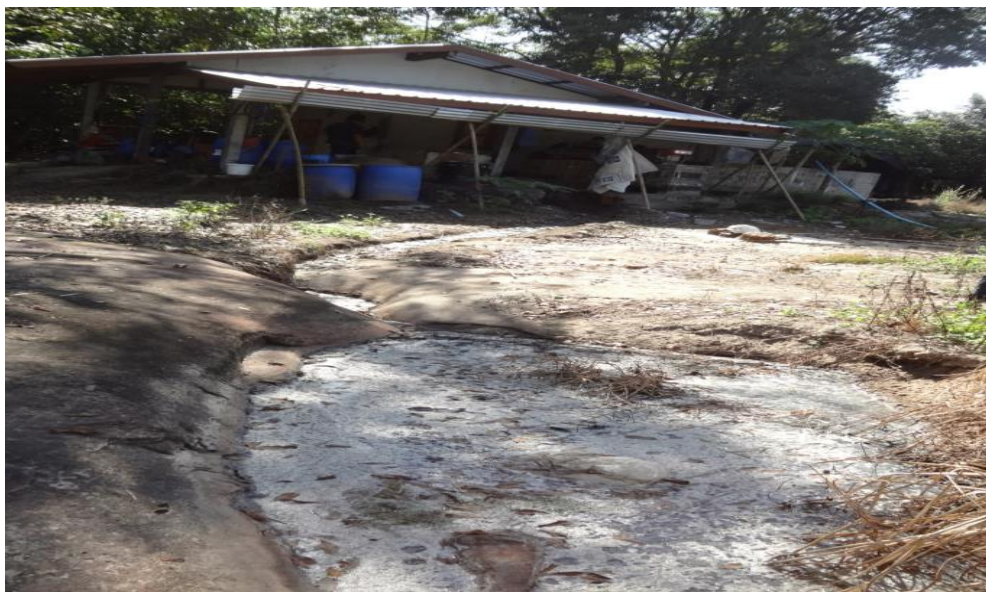
ภาพที่ 3.2 บ่อพักน้ำเสีย
