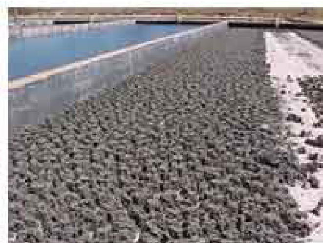
ภาพที่ 2.3 แสดงลานตากตะกอนฐานทราย (Sand Drying Bed)
