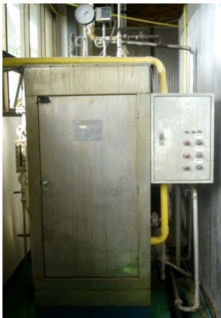
รูปที่ 3.3 เครื่องกำเนิดไอน้ำด้วยไฟฟ้า (บริษัทสหไทย, ประเทศไทย)
