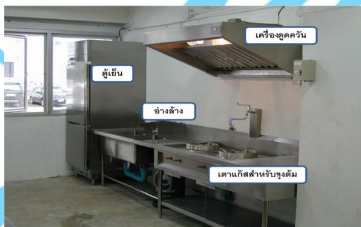
ภาพที่ 2.3 ลักษณะการจัดวางอุปกรณ์ในครัว (ตู้เย็น อ่างล้าง เตาแก๊สสำหรับหุงต้ม และ เครื่องดูดควัน) ที่มา : เลิฟสแตนเลส. 2553. อ่างใน สมยศ ตันติวงศ์วานิช และ พัทธนันท์ ศรีม่วง. 2555 : 15
