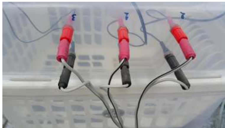
ภาพที่ 3.7 สายไฟเชื่อมอุปกรณ์หลัก
