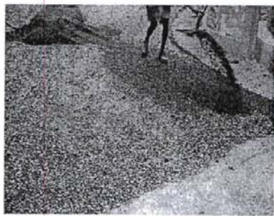
ก) ลาดบางๆ ด้วยยางธรรมชาติผสมแอสฟัลต์บนพื้นที่สะอาด
