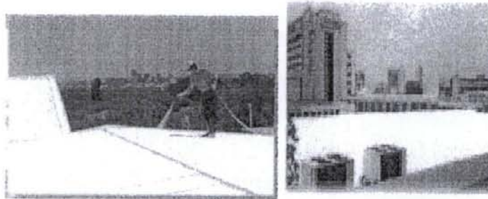
รูปที่ 2.16 บริเวณผิวหลังคาที่มีการใช้เซรามิก ใ้ทตั้ง [6]
