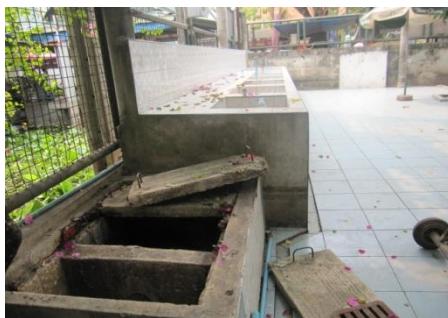
ภาพ 4.4 บ่อดักไขมันบริเวณตลาดน้ำตลิ่งชัน
