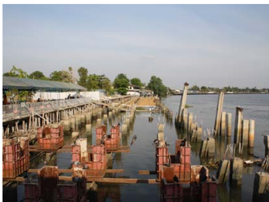
สถานที่ก่อสร้างกันเขื่อนหน้าพระอุโบสถหลังใหม่ยังไม่เสร็จ
