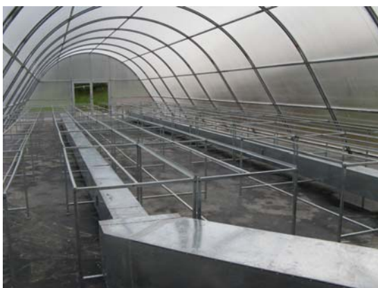
รูปที่ 2 แสดงชั้นวางผลิตภัณฑ์ภายในระบบอบแห้งและท่อกระจายลมร้อนของระบบความร้อนเสริม
