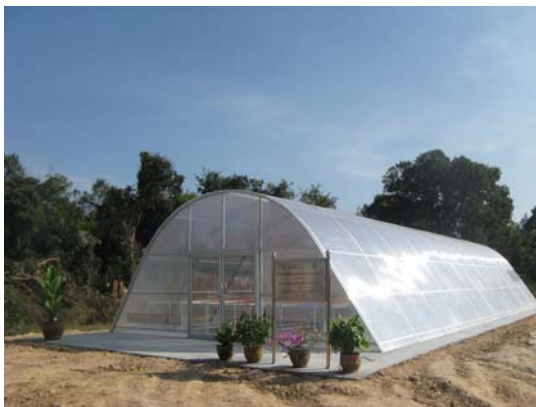
รูปที่ 1 เครื่องอบแห้งพลังงานแสงอาทิตย์แบบเรือนกระจก ตั้งอยู่ที่องค์การบริหารส่วนตำบลหัวเรือ อ.เมือง จ.อุบลราชธานี
